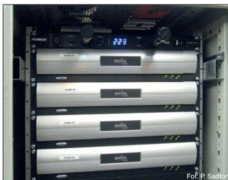
Całością systemu zarządzają urządzenia firmy Biamp Systems: 4 moduły AudiaFLEX spięte CobraNetem + 2 wejściowe moduły analogowe AudiaEXPI.
