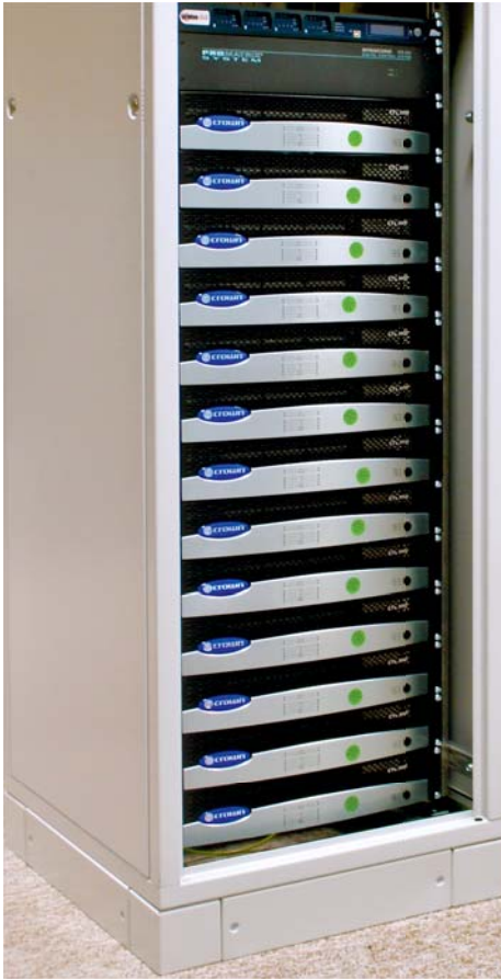
Grona nagłośnieniowe napędzane są przez wzmacniacze Crown CTs 3000 z modułami PIPUSP4, rozmieszczone w czterech amplifikatorniach.
