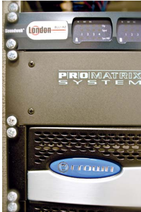
Sygnal analogowy trafia do wzmacniaczy poprzez matryce sygnałowe BSS Soundweb London BLU-80, po jednej na każdą amplifikatornię.
