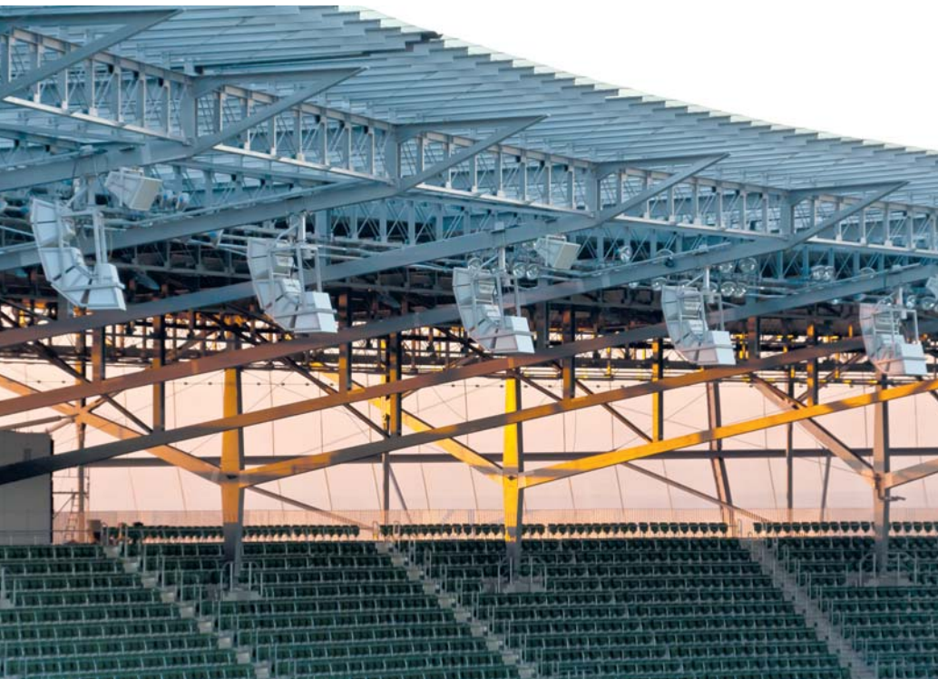
We Wrocławiu zastosowano grona zawierające po trzy szerokopasmowe zestawy głośnikowe plus – nad nimi – dwa subwoofery na dwóch głośnikach 15-calowych.
