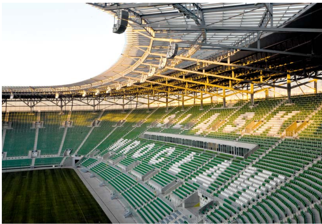
Bryła stadionu ma wysokość kilku pięter, nieco ponad 39 metrów, a podzielona jest na sześć kondygnacji.
