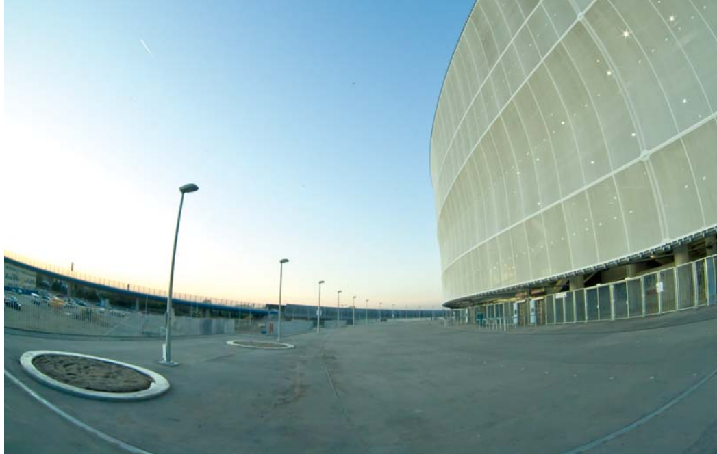
Szkielet stadionu pokryty został siatką z włókna szklanego – ta zaś teflonem – którą można podświetlać różnymi kolorami, w zależności od charakteru odbywającej się w obiekcie imprezy.
